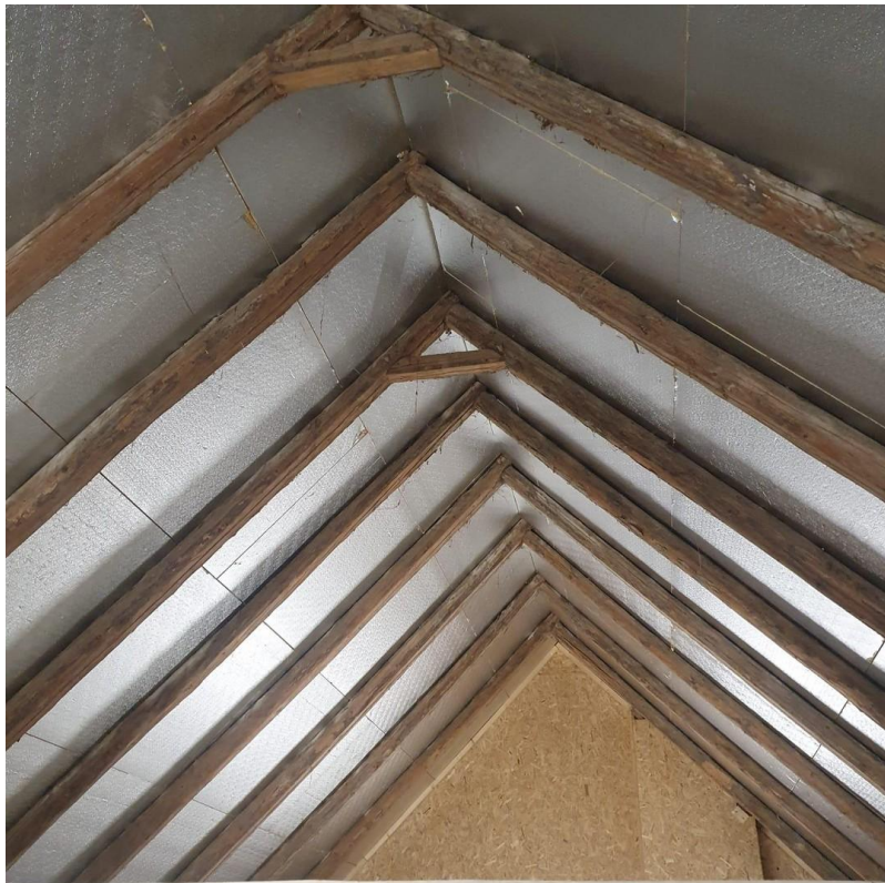
14 cm Aufsparrendämmung
