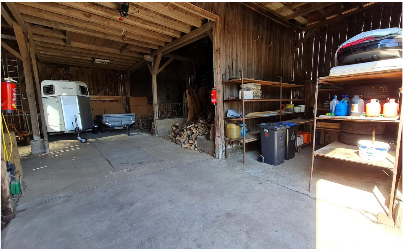
Scheune Einfahrt / Holzlager
