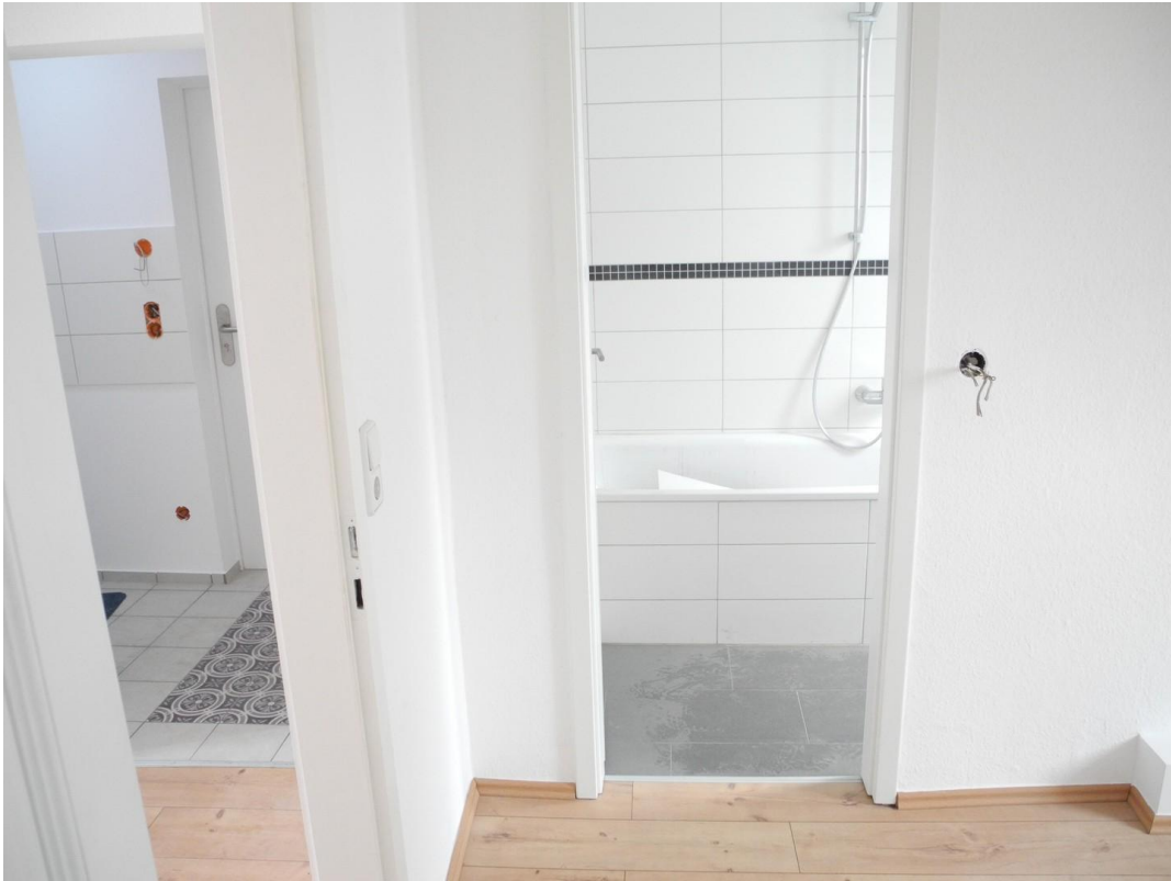
Zugang vom SZ zum Bad
