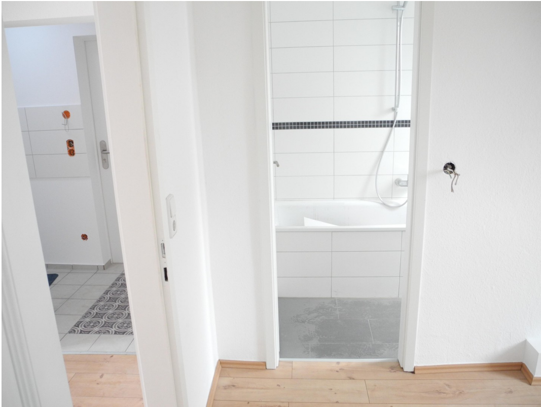
Zugang vom SZ zum Bad
