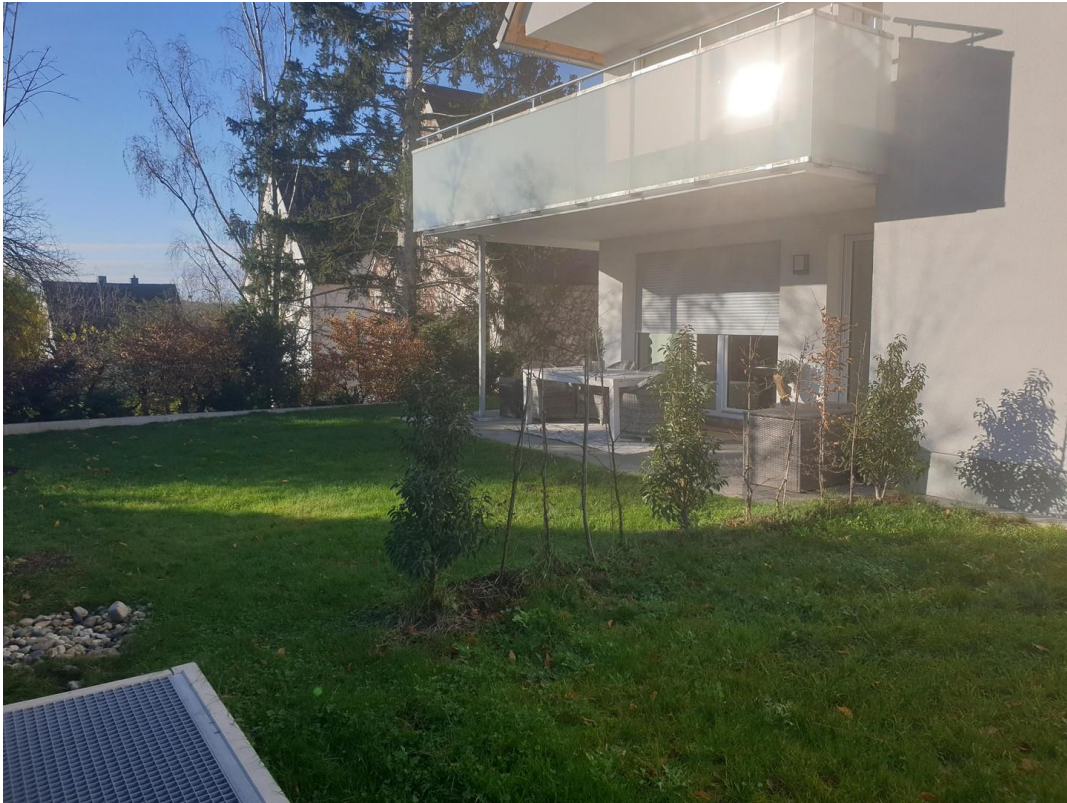
Ansicht Süd Terrasse
