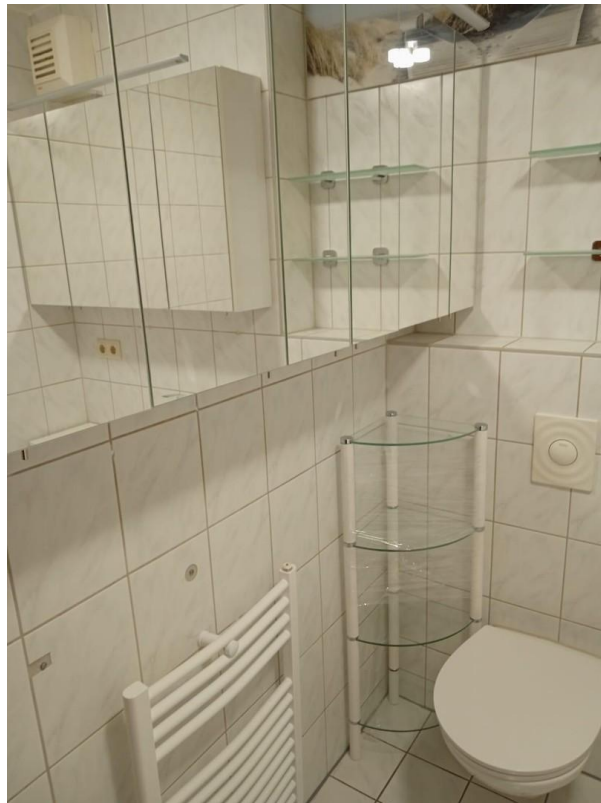
neue Möbel, Handtuchheizkörper
