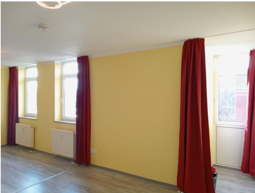
Fensterbänke im Schlafbereich
