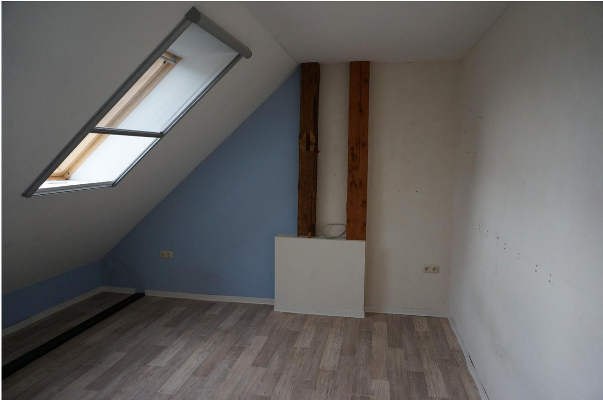
Mögliche Küche od. Zimmer 1.OG
