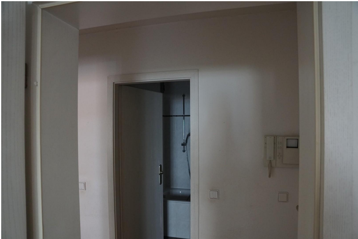
Videosprechanlage in Diele
