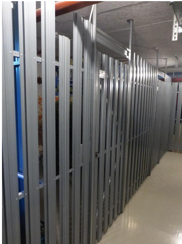
Kellerabteil hinter Metallabtr
