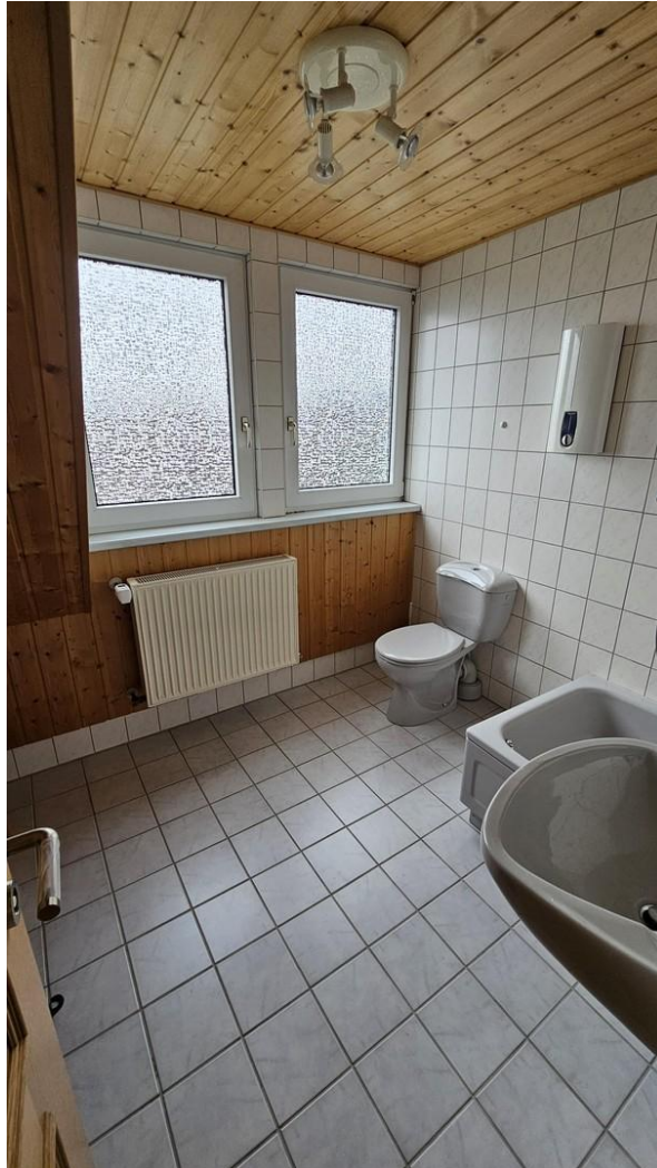
Duschbad DG rechts
