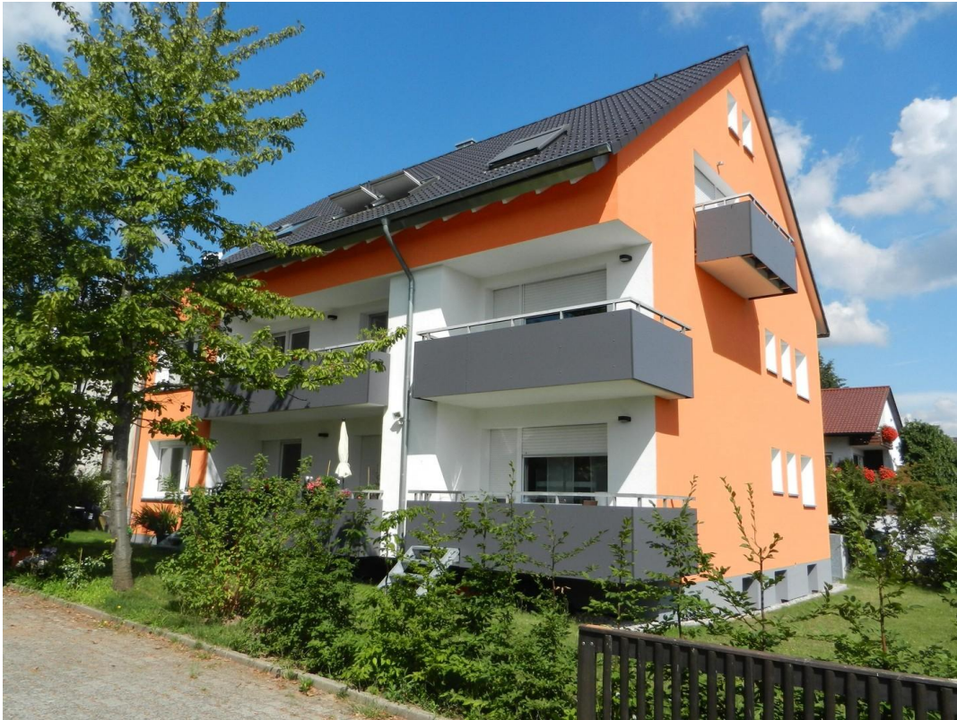
Süd- Ost Fassade
