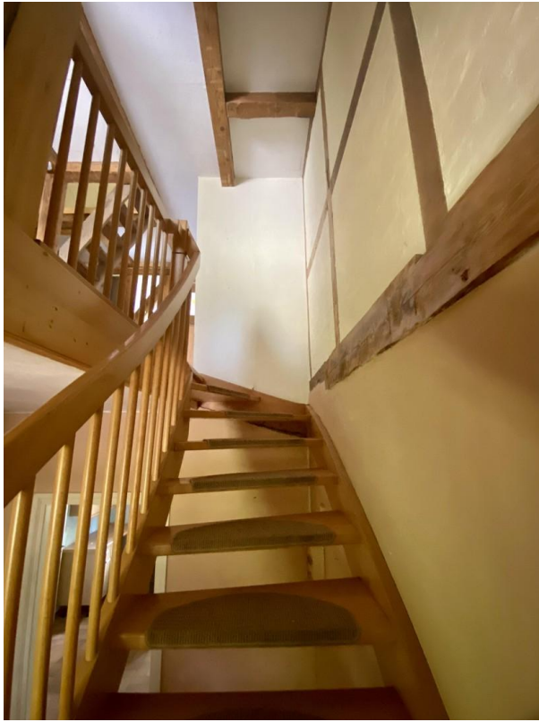
Treppe zur 2. Etage
