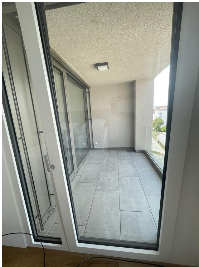
Blick Schlafzimmer - Loggia
