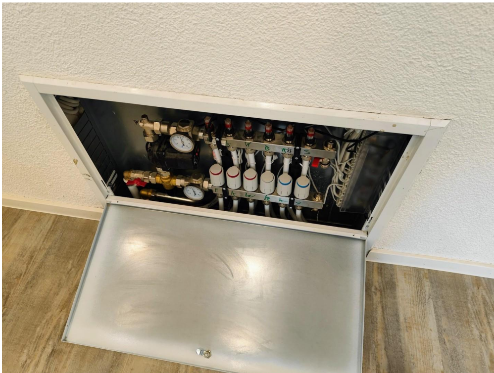
Fussbodenheizung
