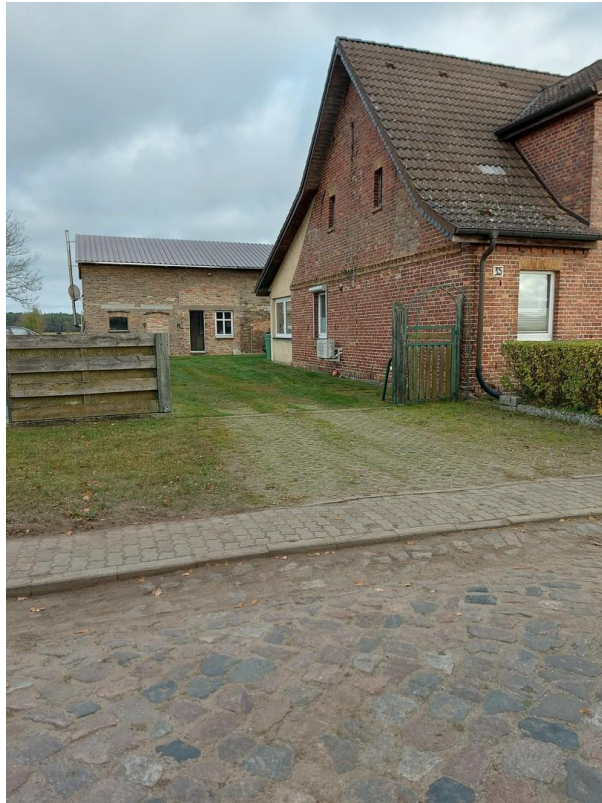
Ansicht mit Auffahrt
