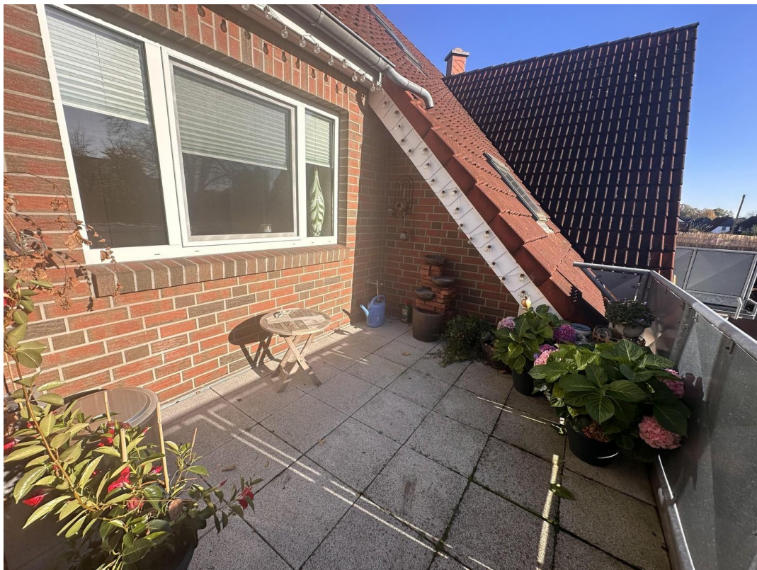
Balkon tieferer Bereich
