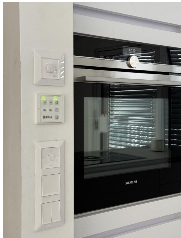
Steuerung Lüftungsanlage/Heiz.
