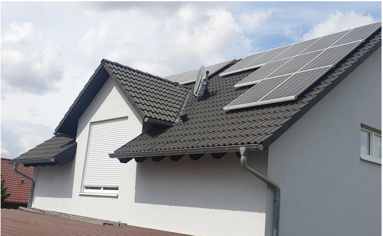
Kfw 40 Plus mit PV-Anlage
