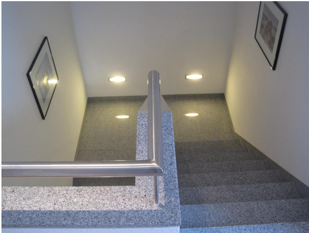
Treppe zwischen 1. und 2. OG
