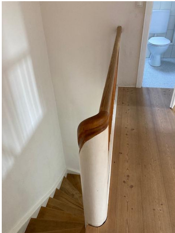
Flur im 1. OG
