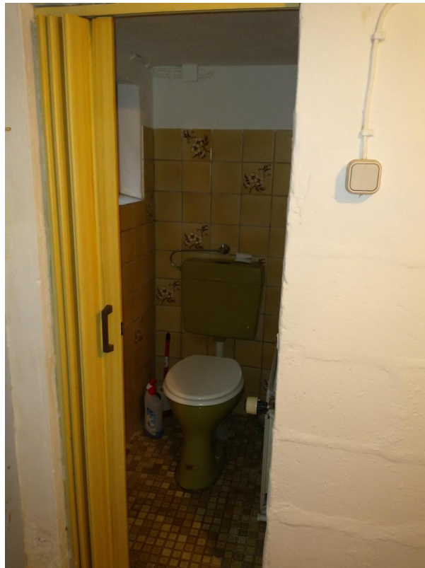
Toilette im Keller
