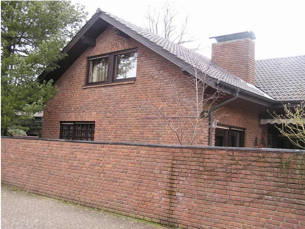
Hausansicht: West- / Südseite
