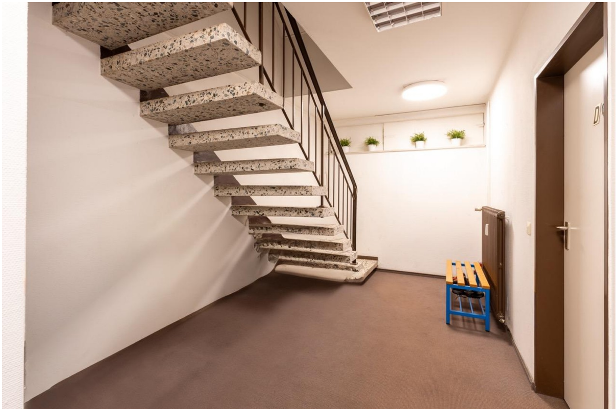
Treppe ins Untergeschoss
