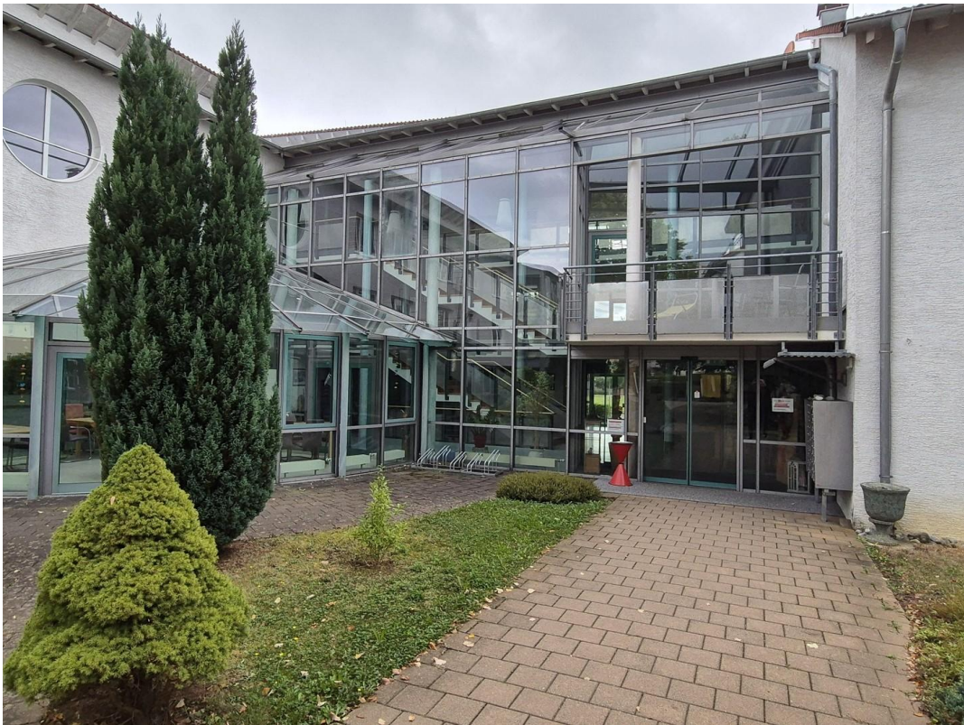
Blick auf das Objekt
