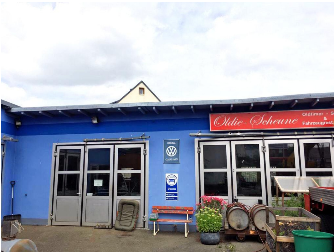
Service- & Haupthalle Außen
