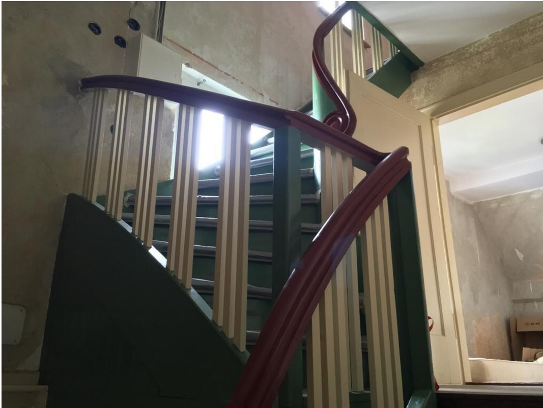
Innenansicht Treppenhaus OG
