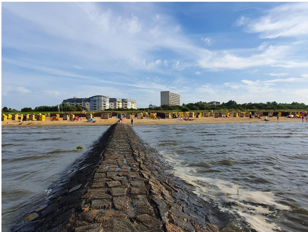
Außenansicht vom Strand
