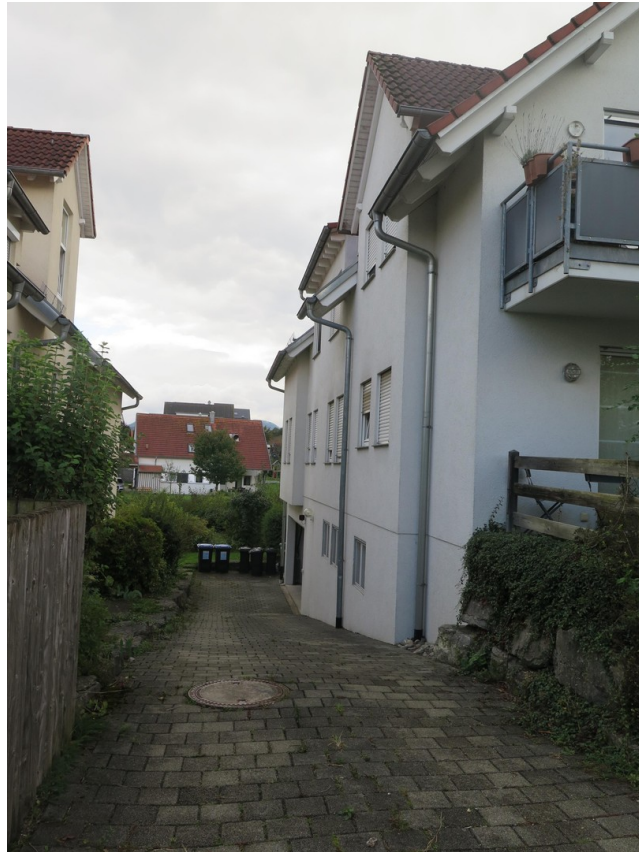
Aussenansicht Zufahrt Garage
