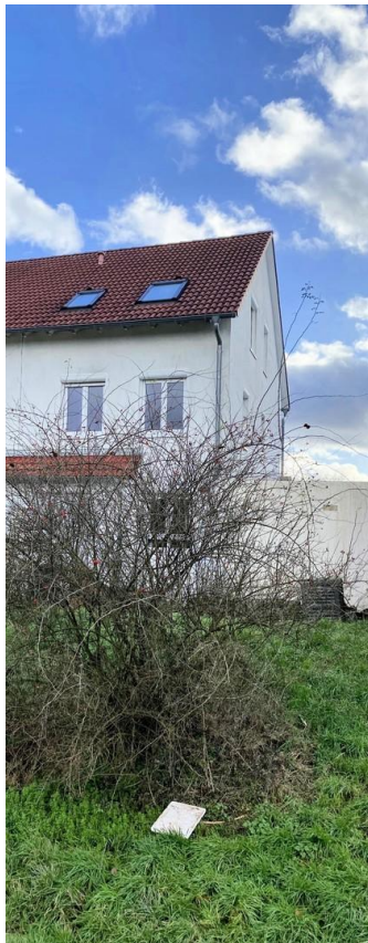
Ansicht Haus hinten
