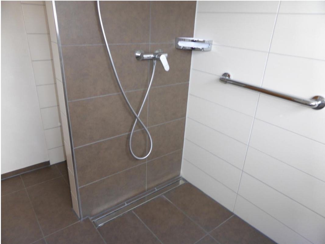
Renoviertes Bad im Erdgeschoss
