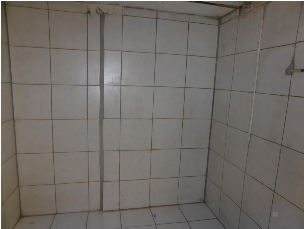
Vorbereitung zum HWR im UG
