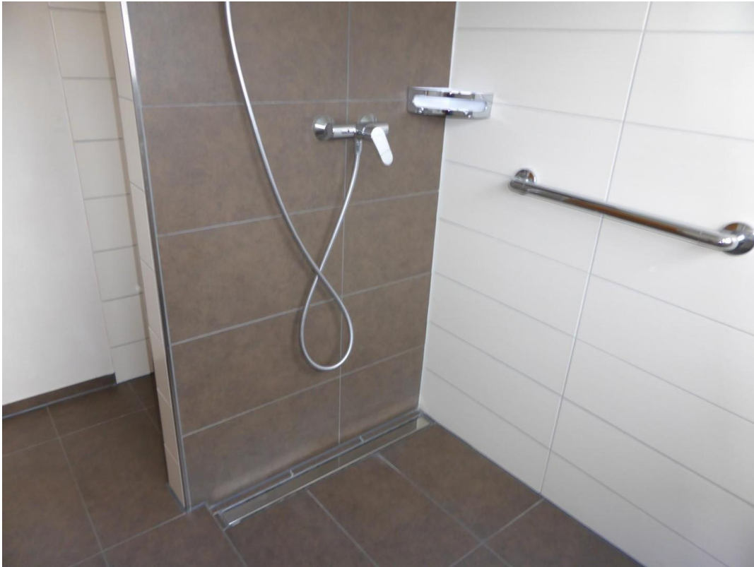
Renoviertes Bad im Erdgeschoss
