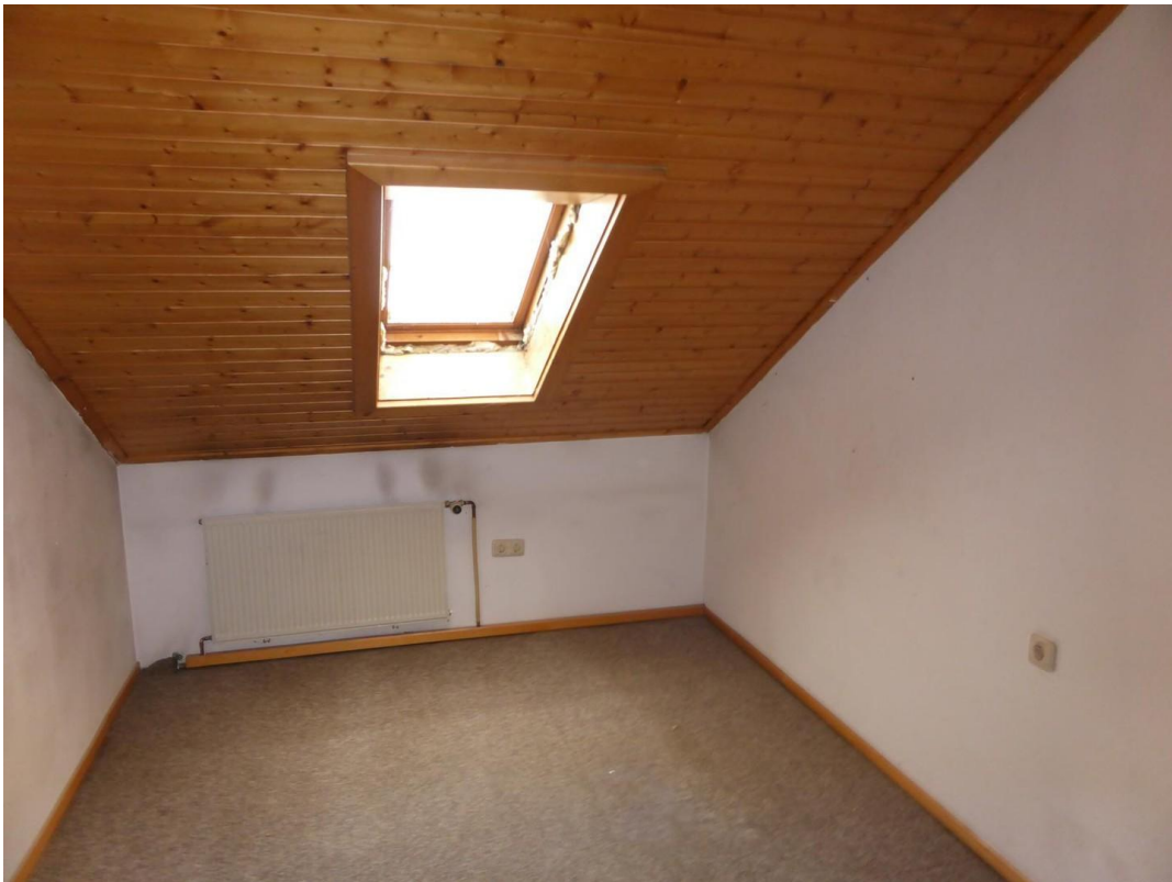
Zimmer im Dachgeschoss
