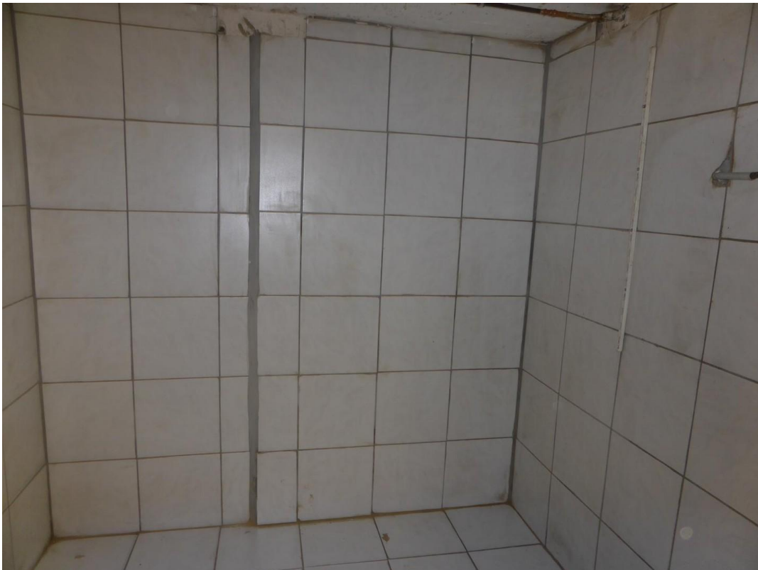
Vorbereitung zum HWR im UG
