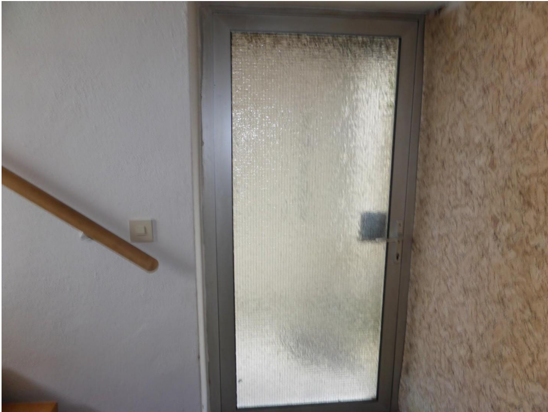
Kellerausgang im Untergeschoss
