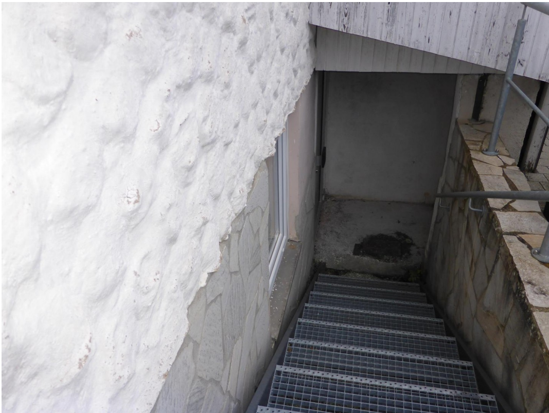
Kellerabgang vom Garten
