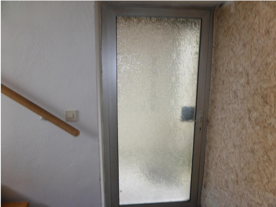
Kellerausgang im Untergeschoss
