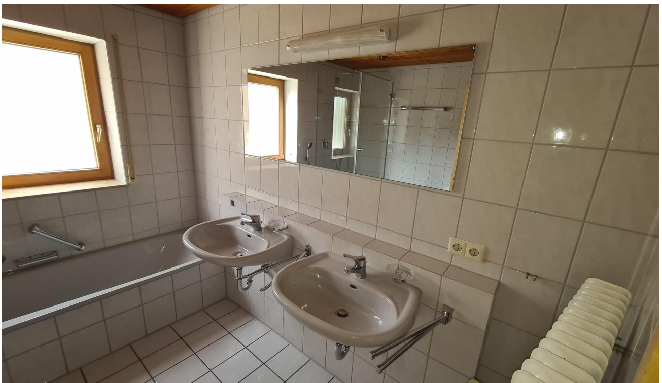
UG Bad,Dusche und Wanne
