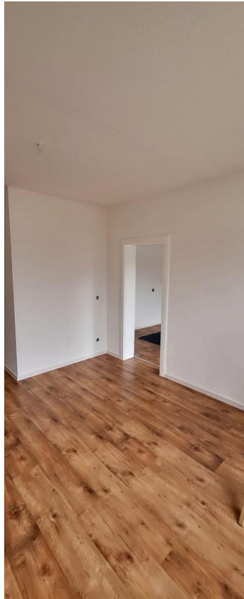
Wohnbereich bei Renovierung
