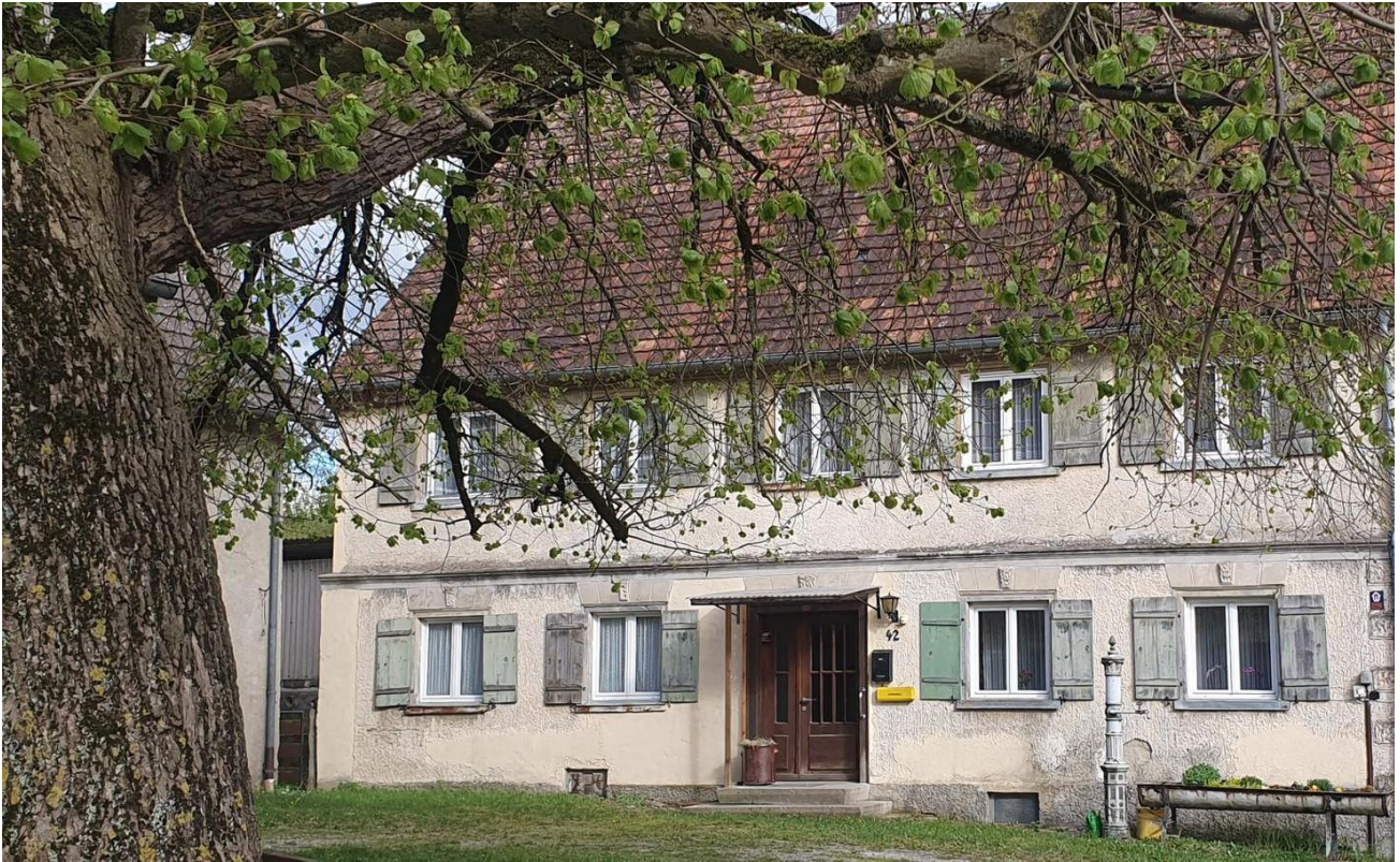
Ansicht Wohnhaus westlich
