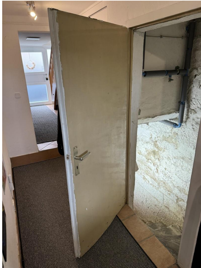
Zugang Keller EG
