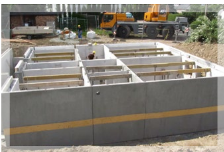
Errichten der Jochstellung für die Montage der Decke.
