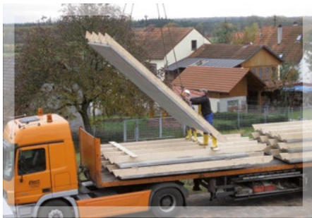
Montage Massivdachelement
