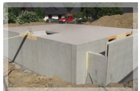
Der fertige Keller.
