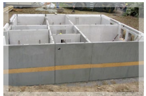
Die Kellerwände sind montiert.
