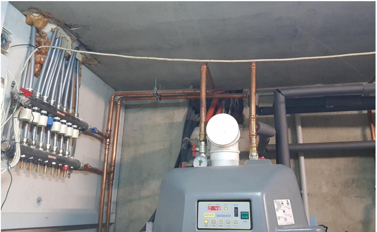
Fussbodenheizung Verteiler 1
