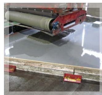
Einfüllen von Leichtbeton
