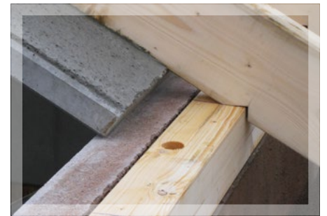
Anschluss Massivelement an Fußpfette
