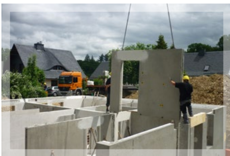
Es erfolgt die Montage der FCN-Innenwände.
