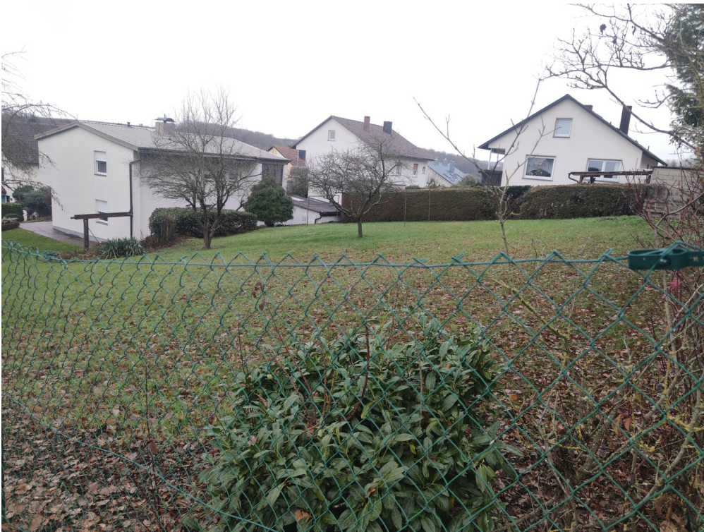
Gebäude Süd/Ost mit Bauplatz b
