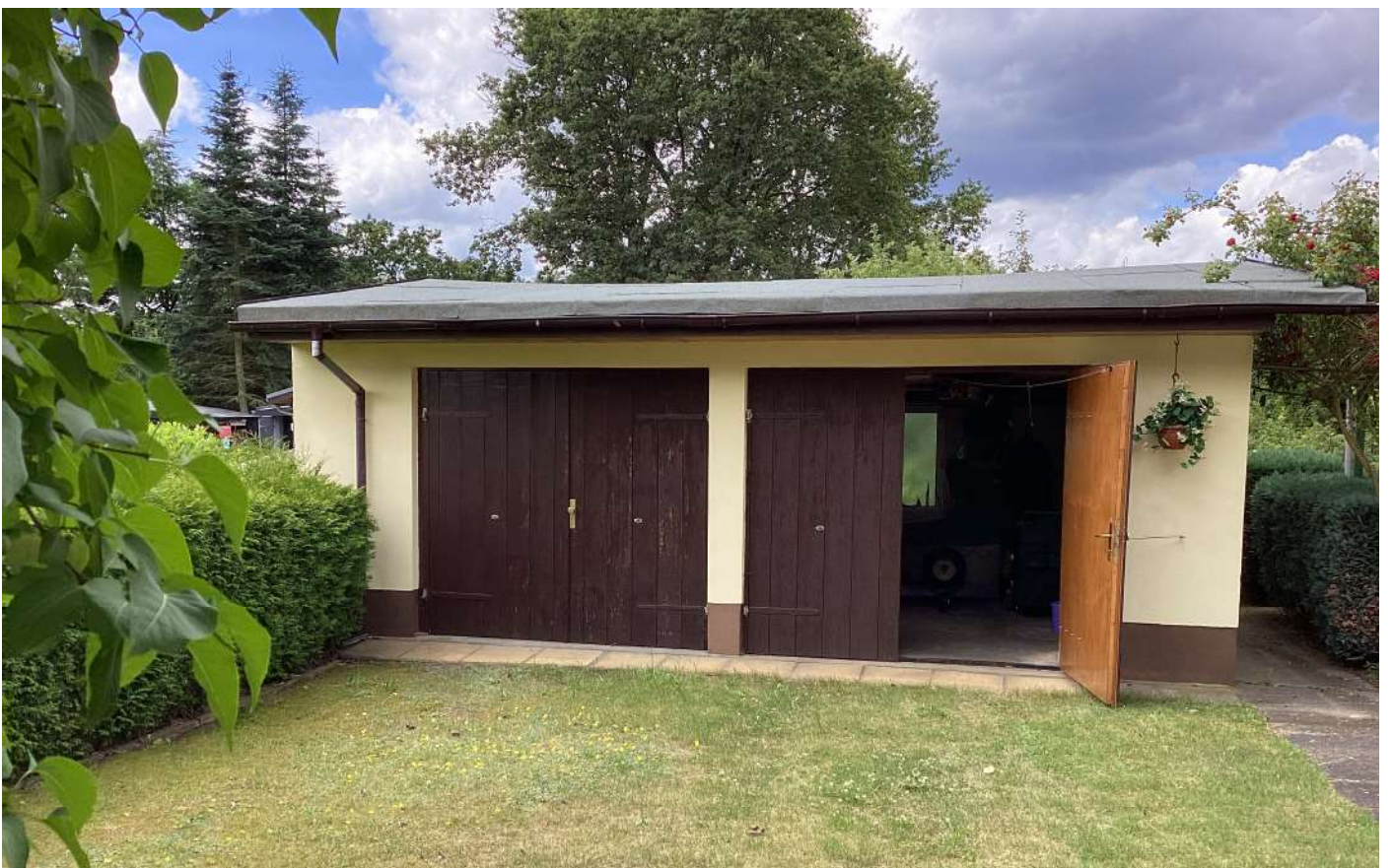
Doppelgarage im Hof
