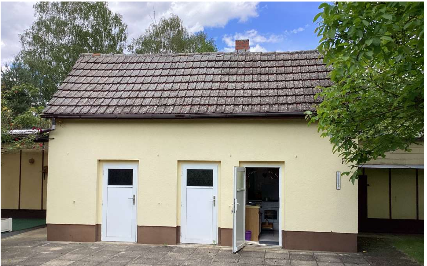
Im ehemaligen Stallgebäude befinden sich heute ein Abstellraum für die Mietpartei, ein Sommerbad mit Badewanne und Waschmaschine und eine Sommerküche.
