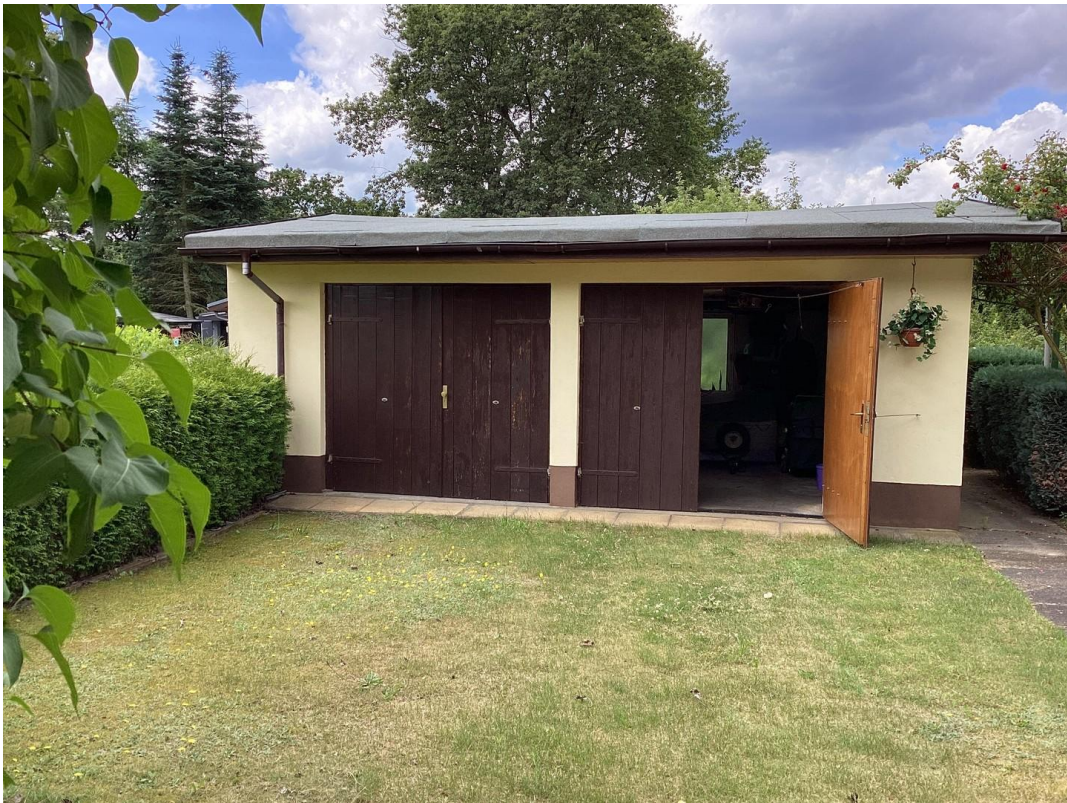
Doppelgarage im Hof
