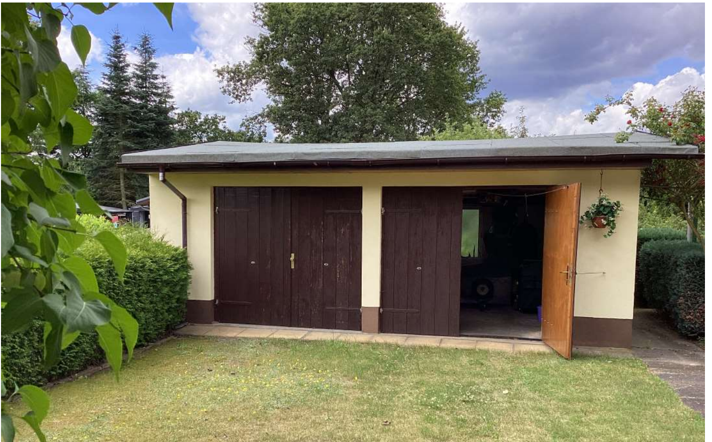
Doppelgarage im Hof
