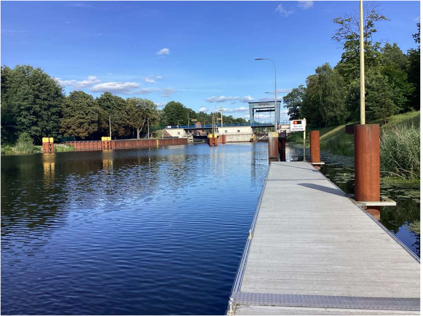
Kersdorfer Schleuse, von hier geht es in den Oder-Spree Kanal
