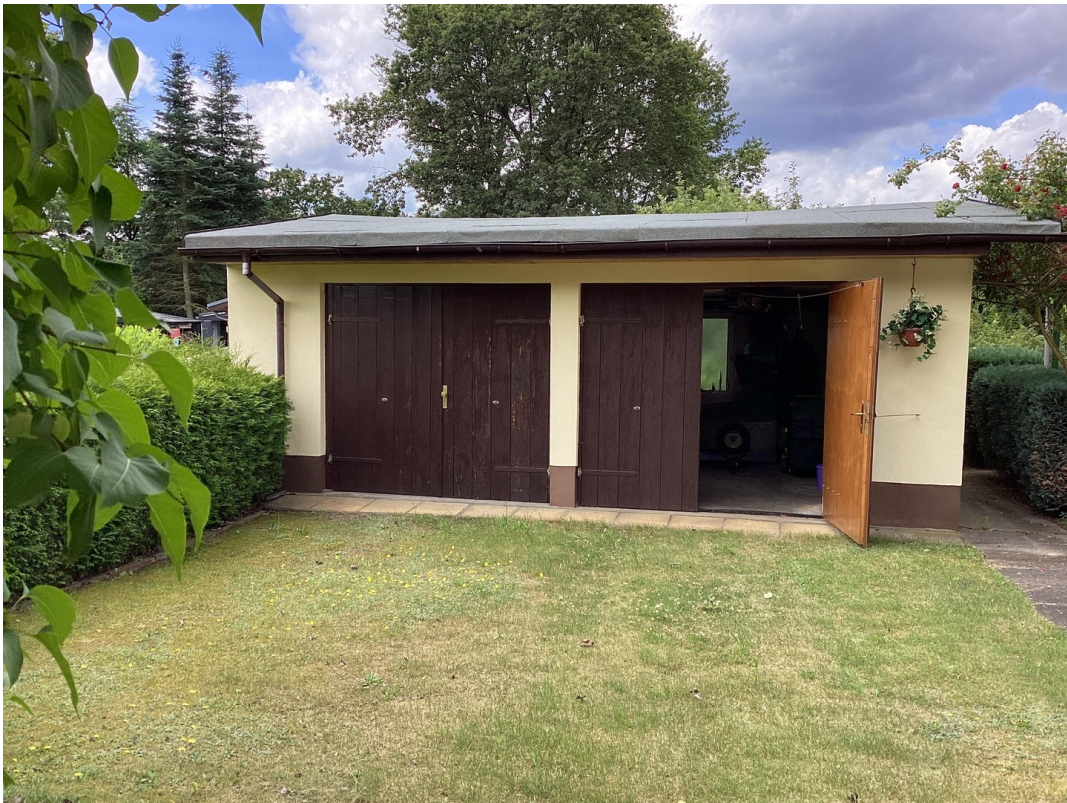
Doppelgarage im Hof
