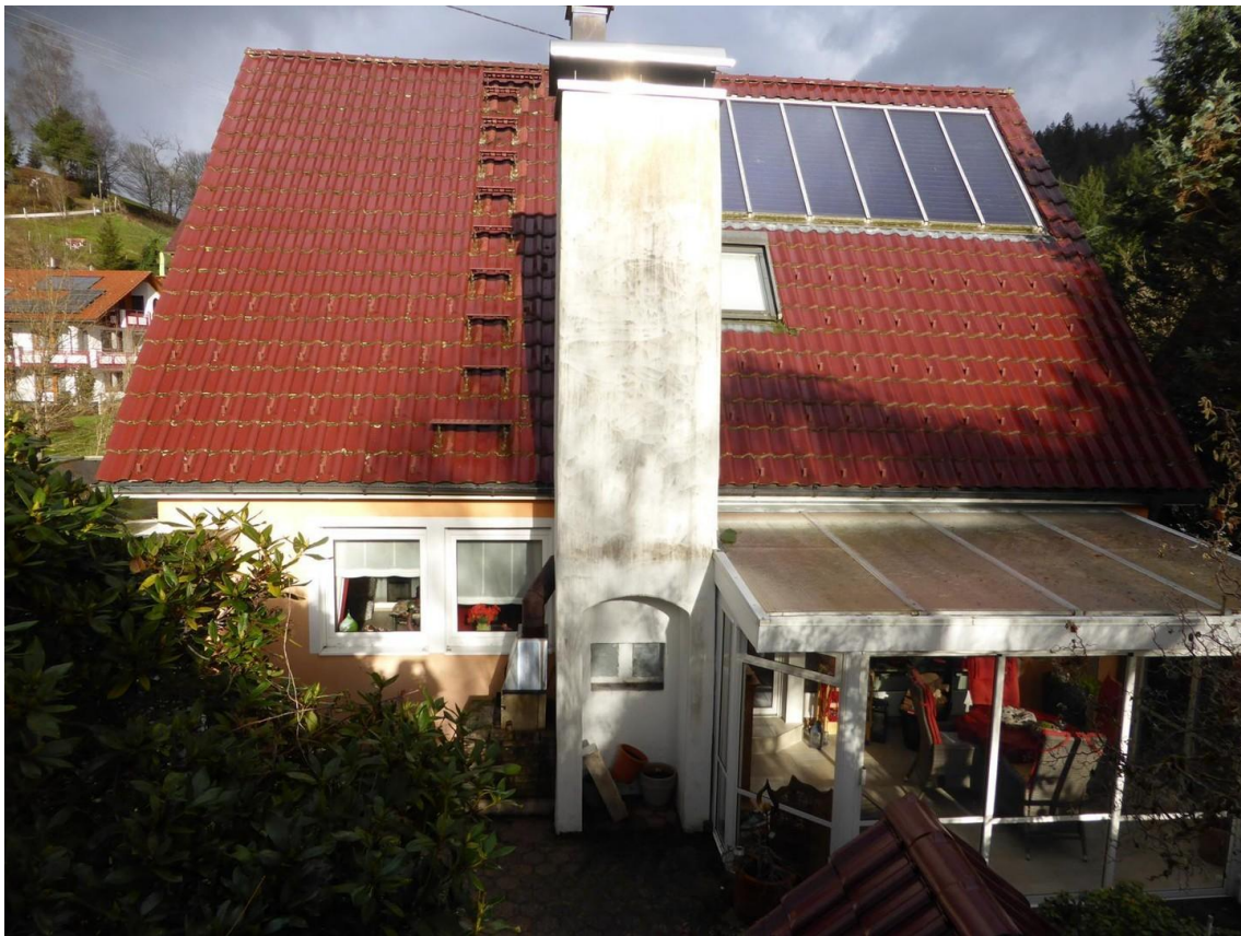
Rückseite Haus mit Solaranlage
