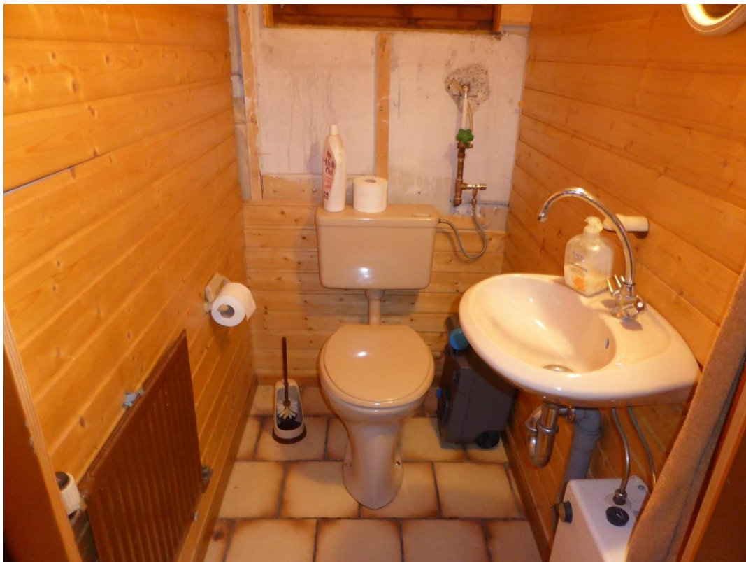
Toilette im Untergeschoss
