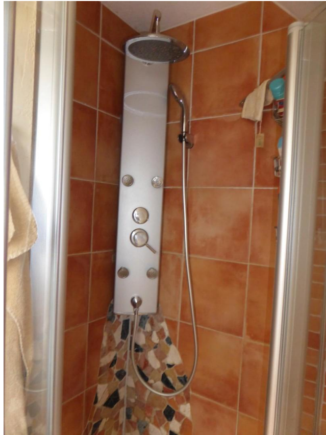
Dusche im Dachgeschoss
