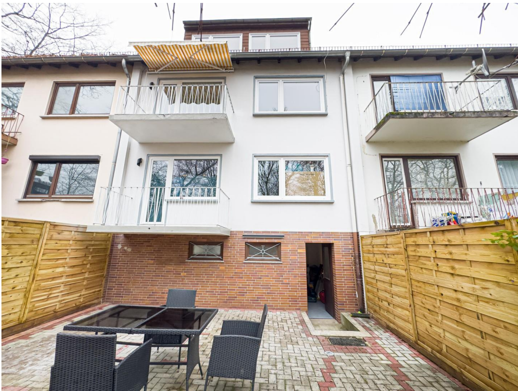
Rückansicht des Gebäudes
