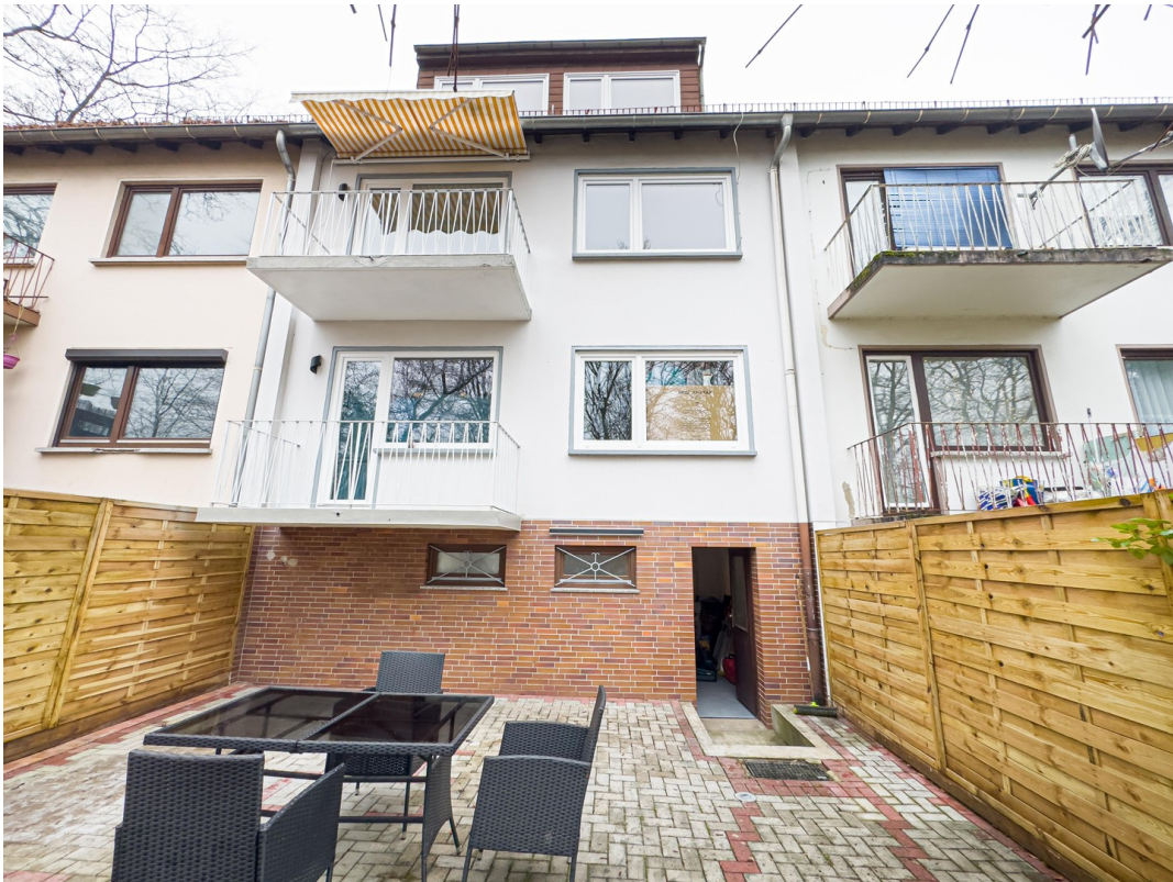
Rückansicht des Gebäudes
