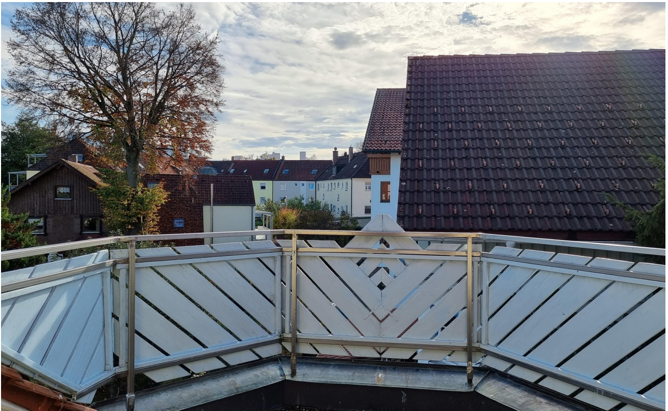
Balkon im Obergeschoß
