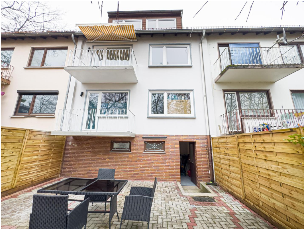
Rückansicht des Gebäudes
