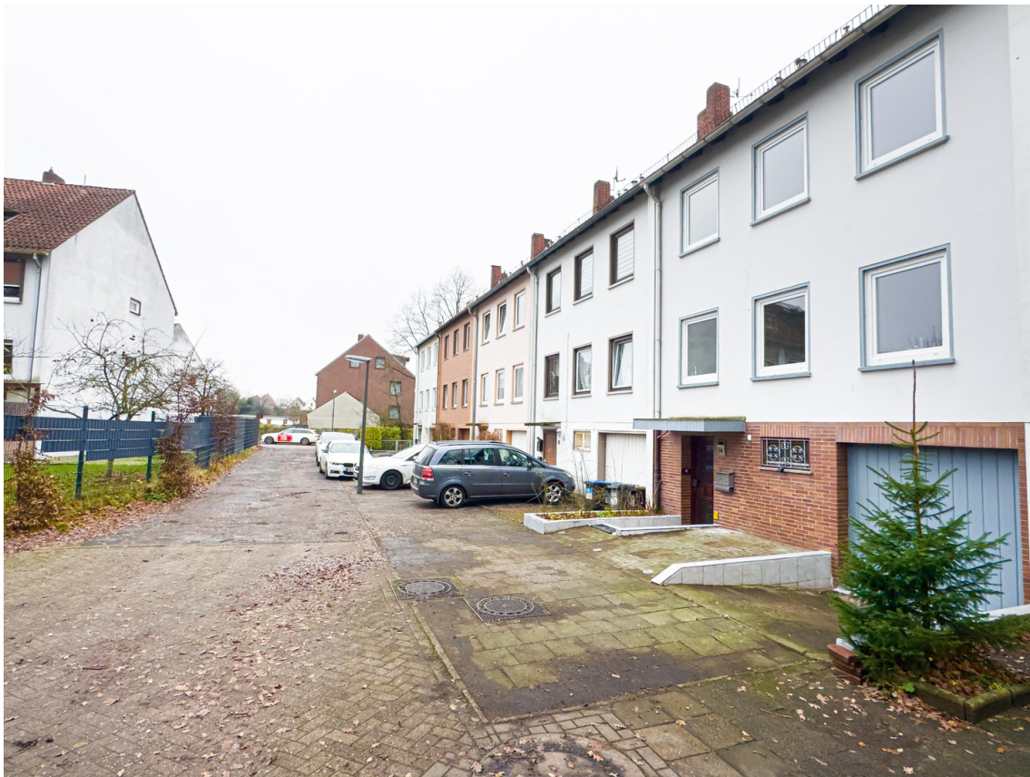
Frontansicht Haus + Straße
