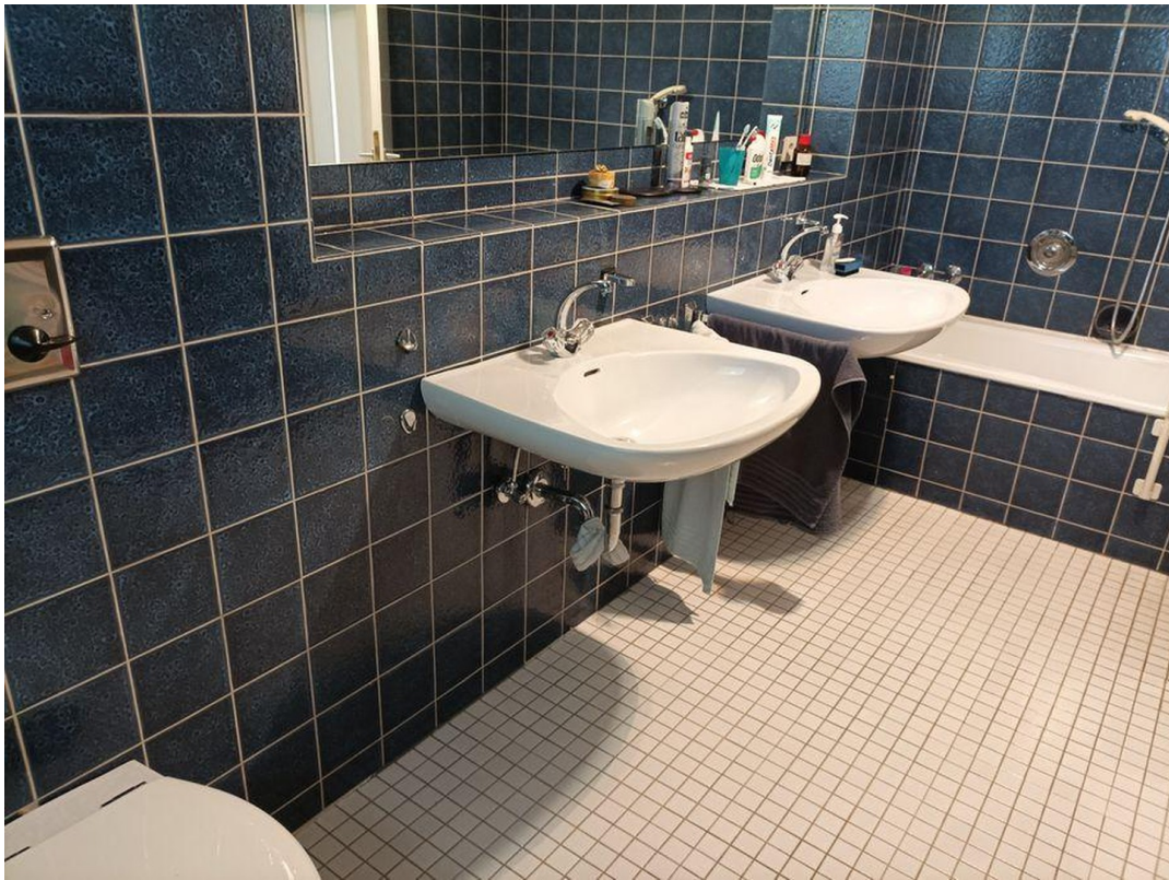
OG Anbau Bad (10)
