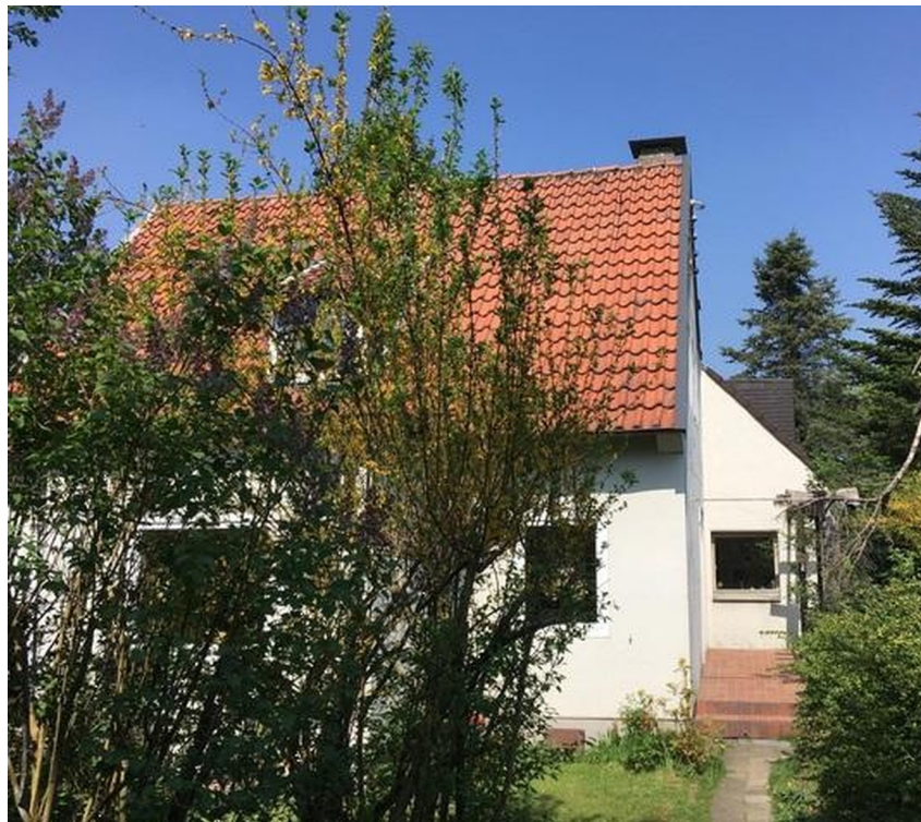
Eingang des Altbaus (3)
