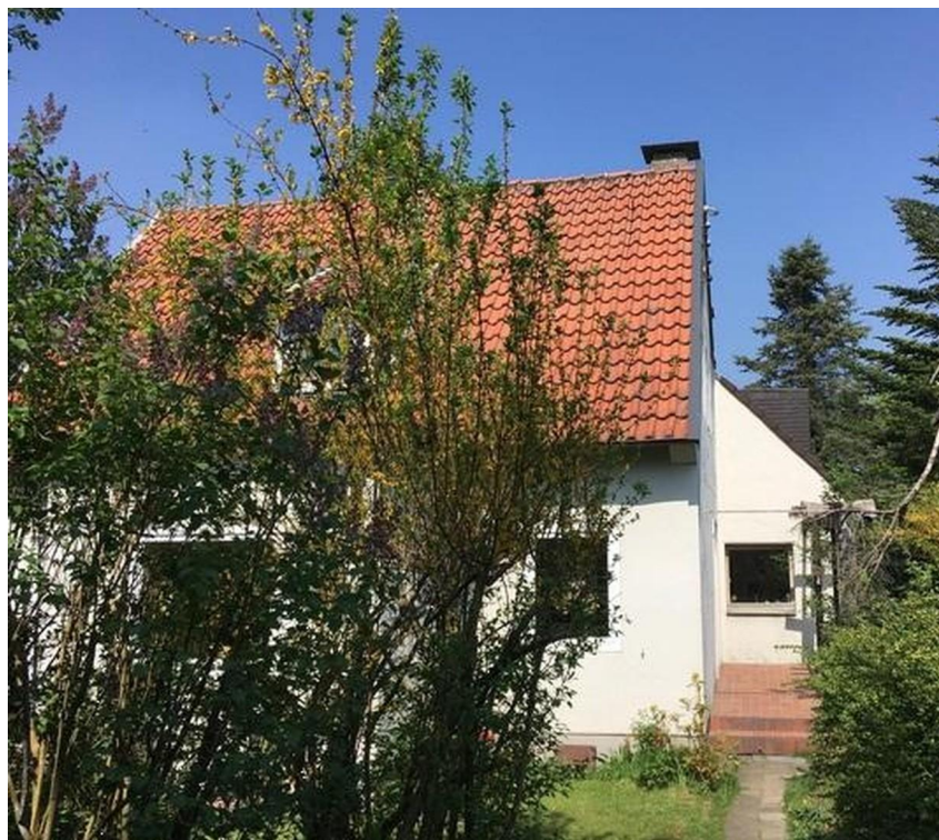
Eingang des Altbaus (3)
