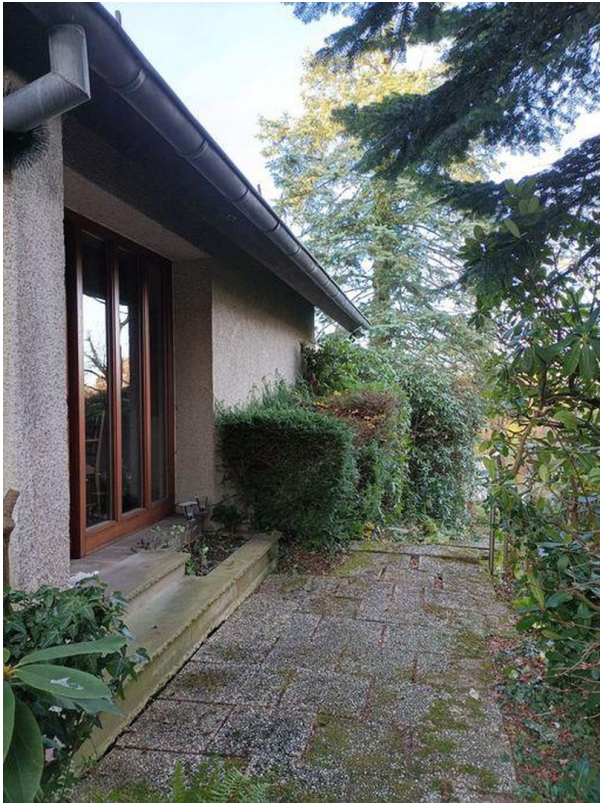
Eingang des Anbaus
