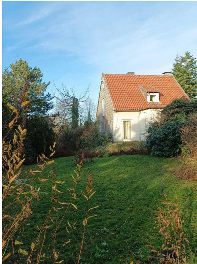
Seitenansicht des Altbaus (2)
