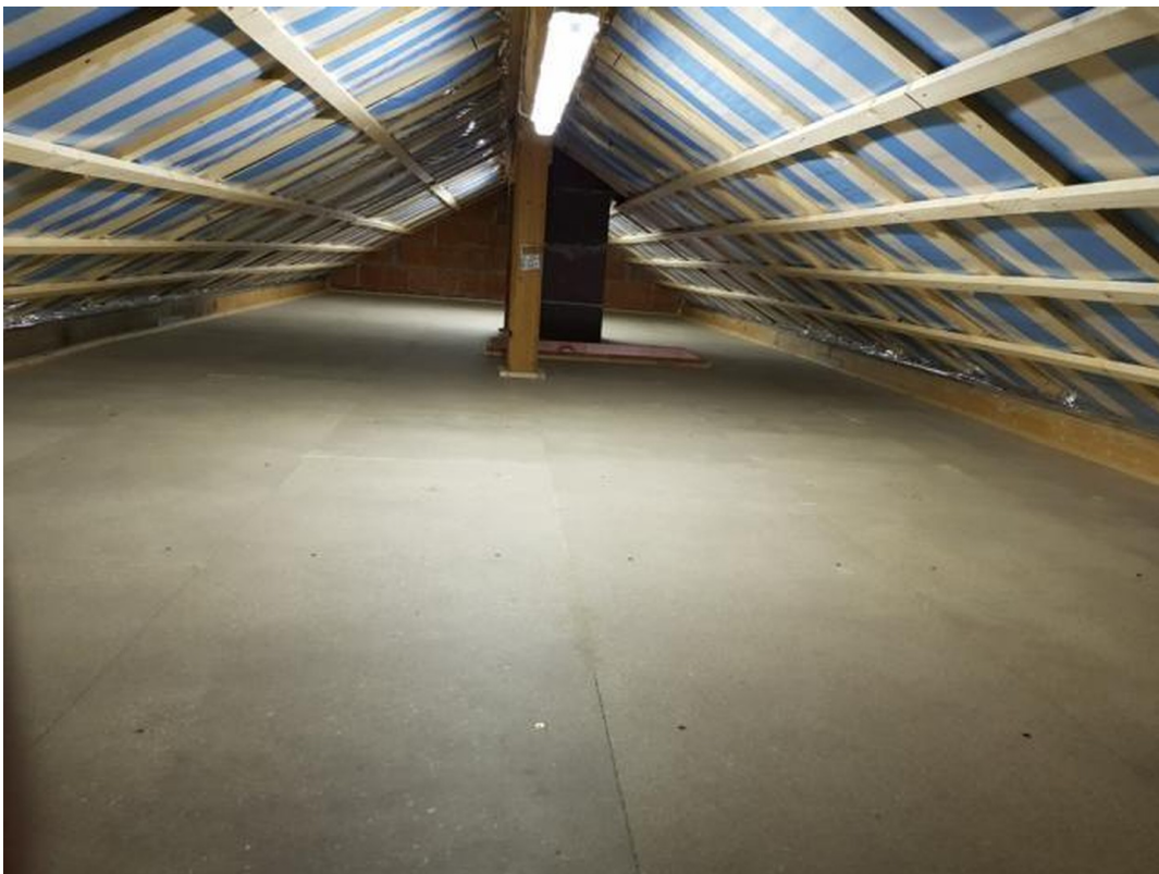
Dachboden komplett ausgebaut
