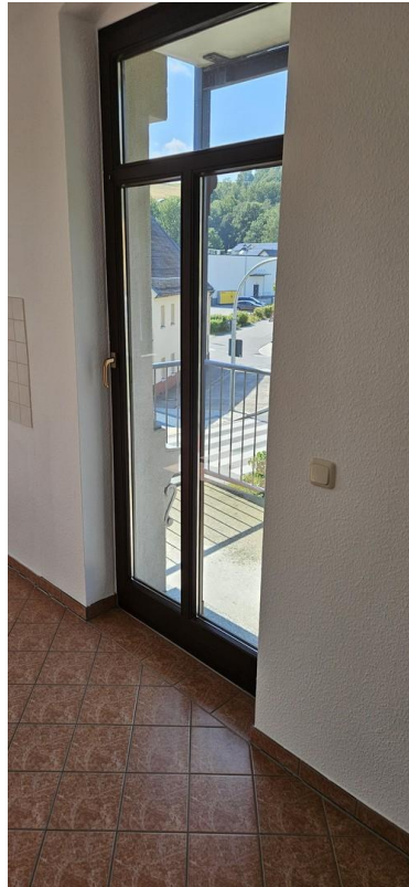
Küche (vor Renovierung)
