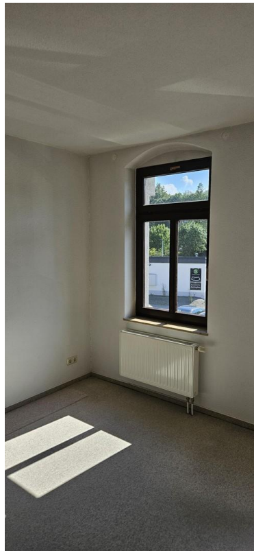
Wohnzimmer (vor Renovierung)
