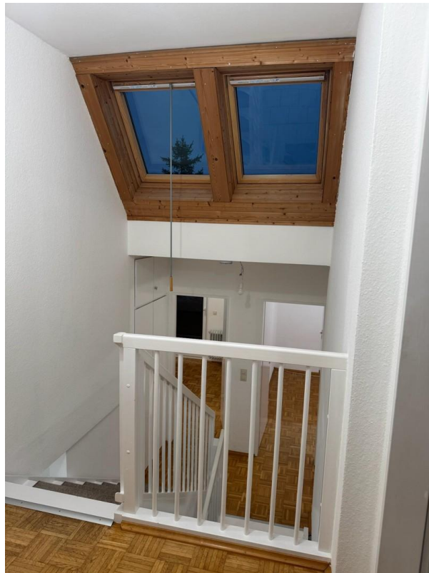
Dachfenster im Treppenhaus
