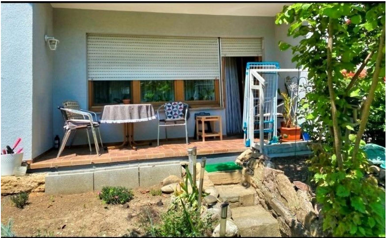
EG Links, Terrasse
