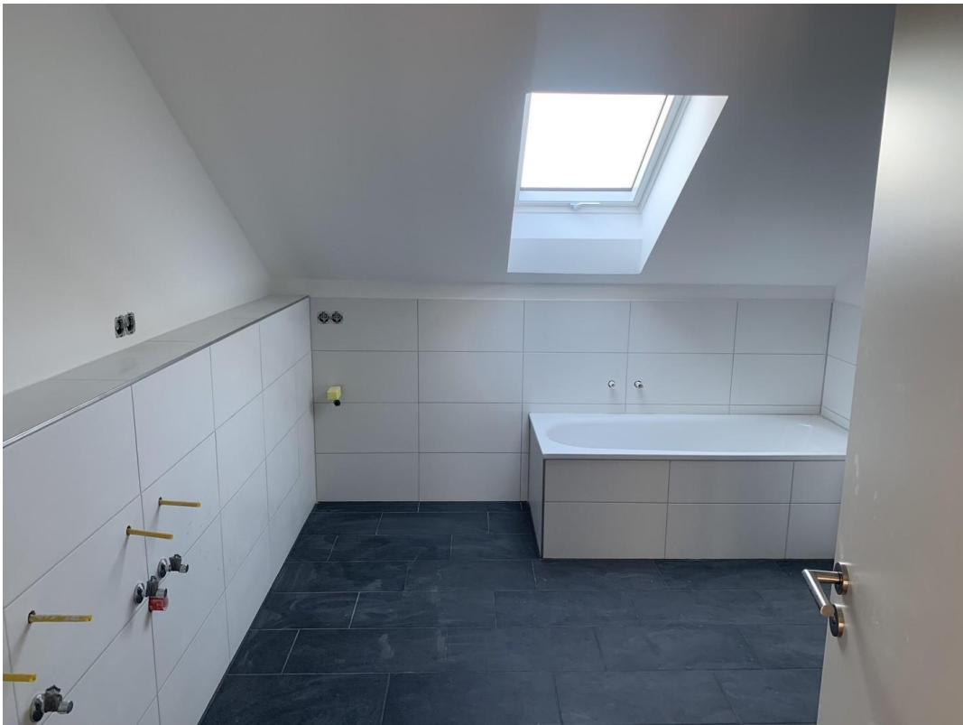
Bad (Foto aus Bauphase)
