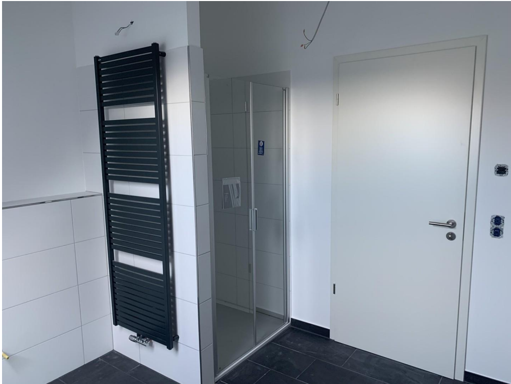
Bad (Foto aus Bauphase)
