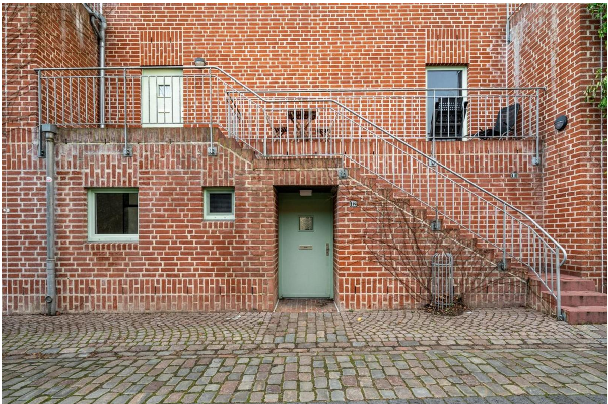
Privater Zugang und Terrasse
