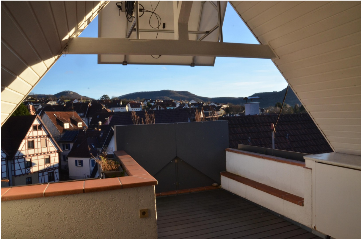
Dachterasse mit Altrauf
