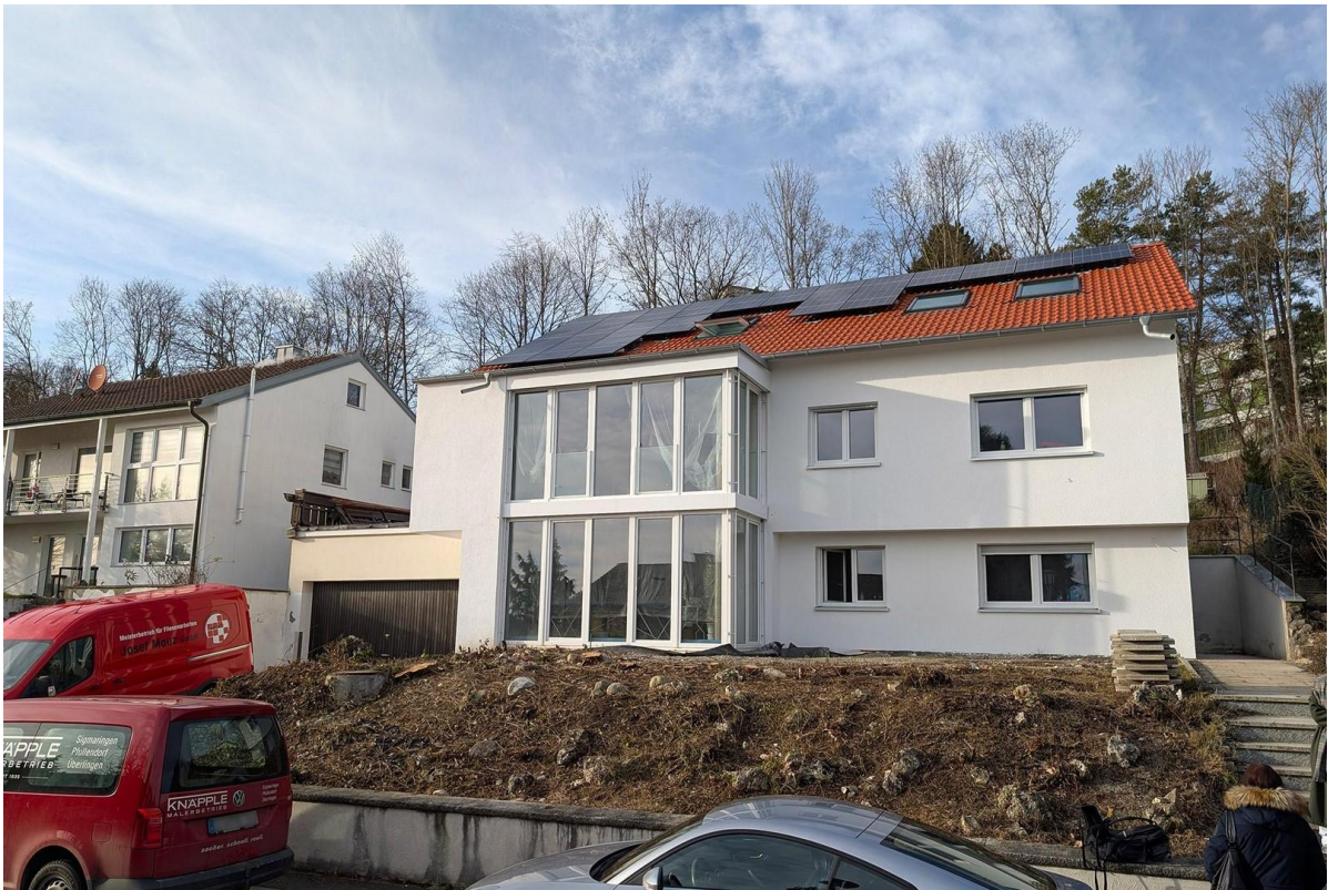
Außenansicht von Straße SO
