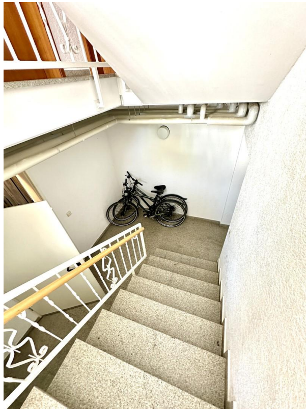
Treppenhaus zum Keller
