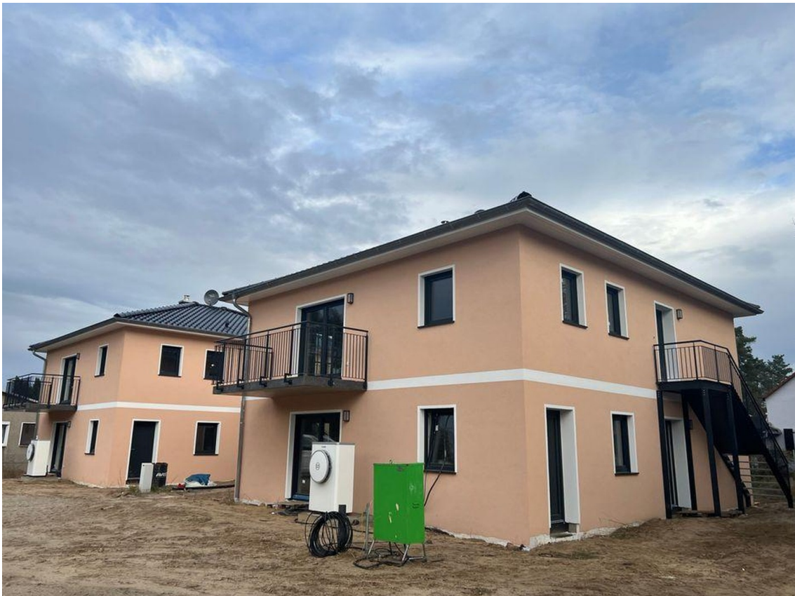
Außenansicht 5 A + 5 B
